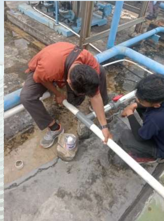
● TINDAK LANJUT PERBAIKAN : Dilakukan Instalasi Bypass Pipa Suply Air Bersih untuk perbaiki Rooftank
